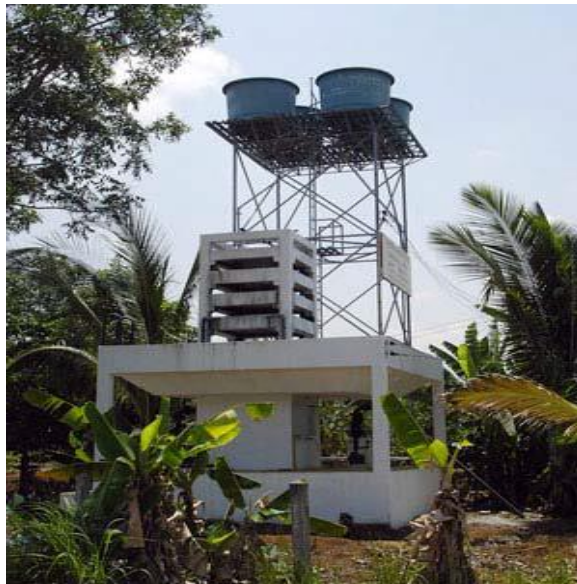
รูปที่ 16 ตัวอย่างรูปแบบระบบประปาหมู่บ้านของกรมการเร่งรัดพัฒนาชนบท
