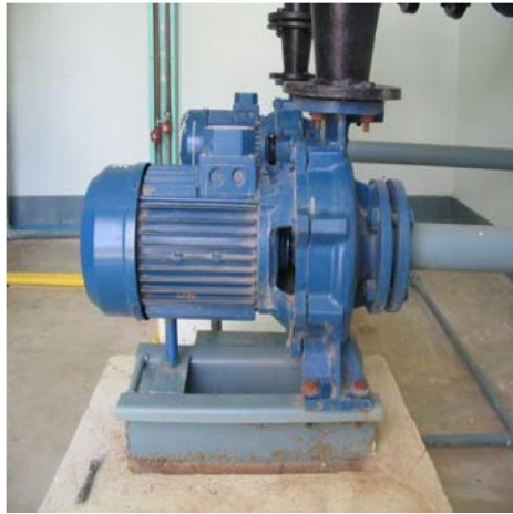
(5) เครื่องสูบน้ำดี (แบบหอยโข่ง)
