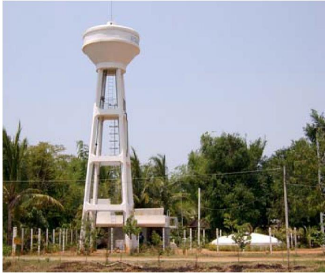
รูปที่ 15 ตัวอย่างรูปแบบระบบประปาหมู่บ้านของกรมอนามัย
